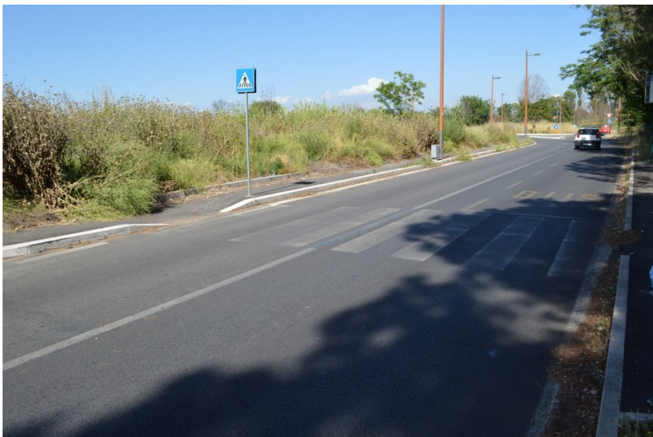
Foto 8 – Passaggio pedonale su via di Tor Carbone all'altezza delle due fermate dell'autobus 765 (Laurentina-Arco di Travertino).
